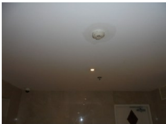
ภาพที่ 5-22 Smoke Detector และ Sprinkler
