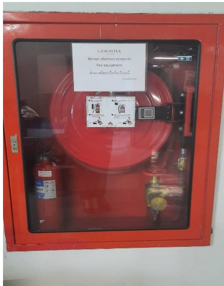
ภาพที่ 5-20 ตู้เก็บสายฉีดน้ำดับเพลิงพร้อมอุปกรณ์ และถังดับเพลิง ABC และมีป้ายแนะนำวิธีการใช้
