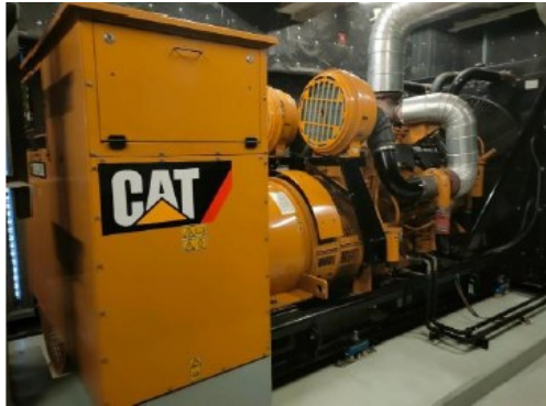
ภาพที่ 5-17 ห้องเครื่องกำเนิดไฟฟ้าสำรอง
